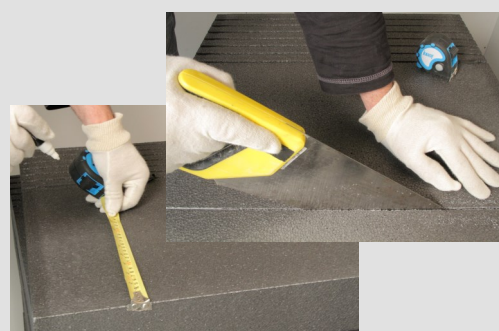
2– Découper les panneaux à la mesure + 1cm
