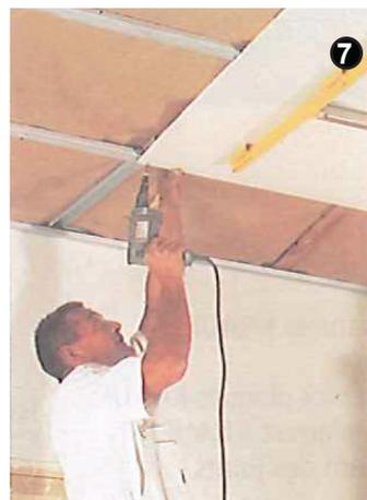
Les plaques sont mises en place grâce à un lève-plaque et sont ensuite vissées sur l'ossature (Fig 7).
